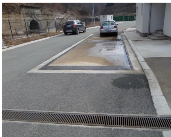
Slika 8. Vaga za vaganje vozila sa komunalnim otpadom koja ulaze na transfer stanicu
