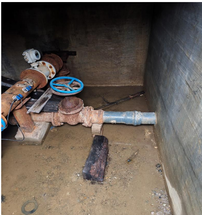
b) Merno mesto broj 2: kružni tok Miloša Obilića br.1, u postojećem šahtu, postavlja se merilo protoka DN 80. Slike u nastavku:
