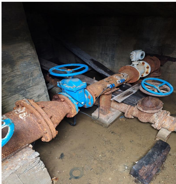
b) Merno mesto broj 2: kružni tok Miloša Obilića br.1, u postojećem šahtu, postavlja se merilo protoka DN 80. Slike u nastavku:
